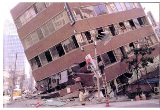
ピロティ形式構造の崩壊 朝日
